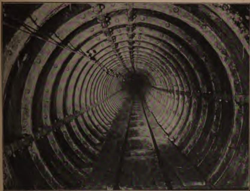
Fig. 251. — Vue perspective du revêtement métallique.
